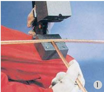
Kaynak yapılabilmesi için kalbin kuru ve temiz olduğundan emin olduktan sonra iletkenleri kalbin içine yerleştirin.
